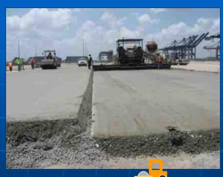
ROLLER COMPACTED CONCRETE
